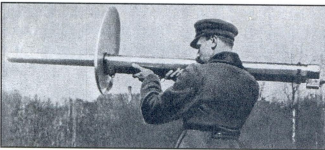
Испытания безоткатного реактивного ружья Петропавловского, 1931 г.
